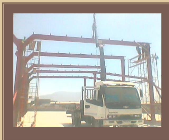
Estas fotos corresponden a un montaje de 10.000 mt<sup>2</sup> de tubest, el material que se usa actualmente para la fabricación de galpones (naves).
